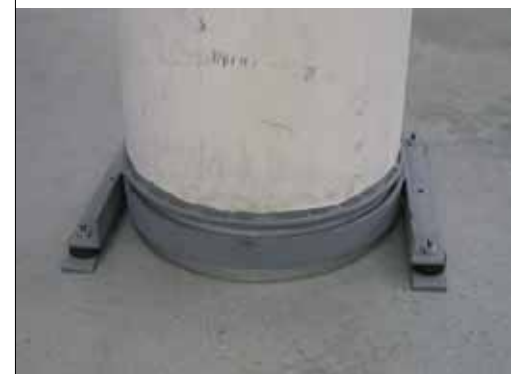
Usazení trubek v upevňovacím rámu.
