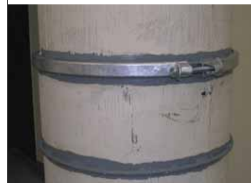
Stahovací spona na spojích trubek.
